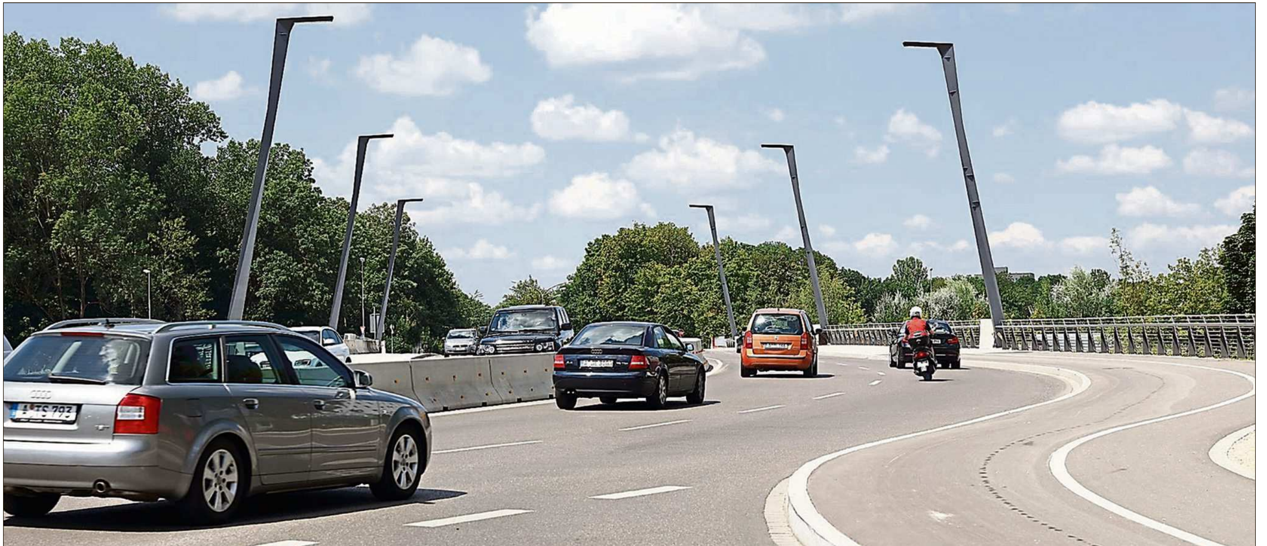
Sechs Mastleuchten flankieren die vierspurige Straße in einem Abstand von 55 Metern.
