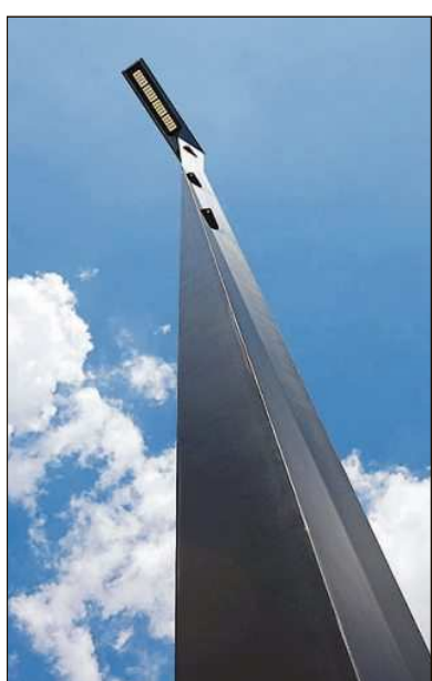
Zwölf Meter hohe Leuchten.
