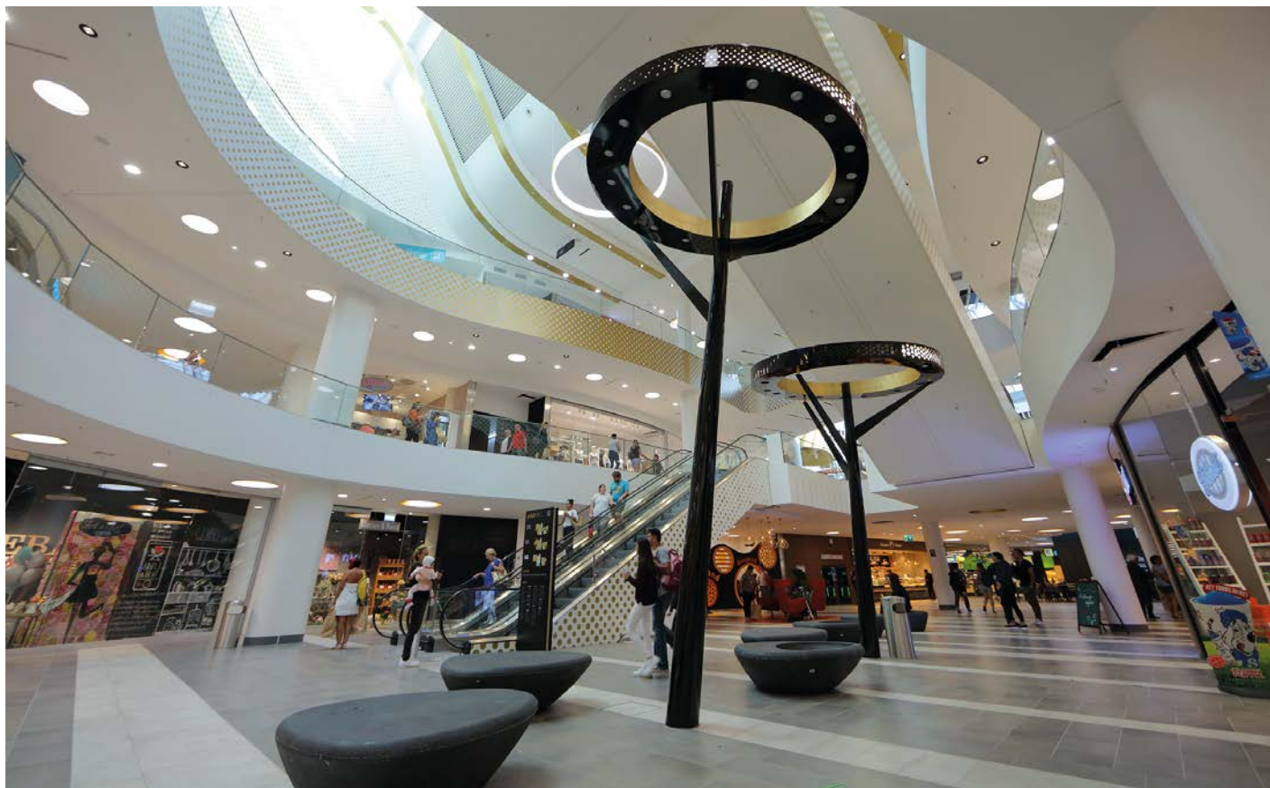
Abb.: Bis zu 10 m hohe Lichtbäume erhellen das Atrium. Die LED-Downlights und seitlich abstrahlenden LED-Bänder in den ringförmigen Mastaufsätzen lassen sich tageslichtabhängig ansteuern.
