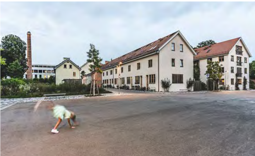
Der historischen Bausubstanz angepasster Wohnungsbau
